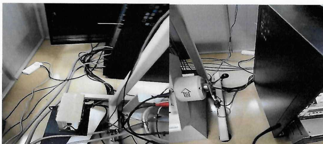
104 插板应有效固定，不要直接放地板。
